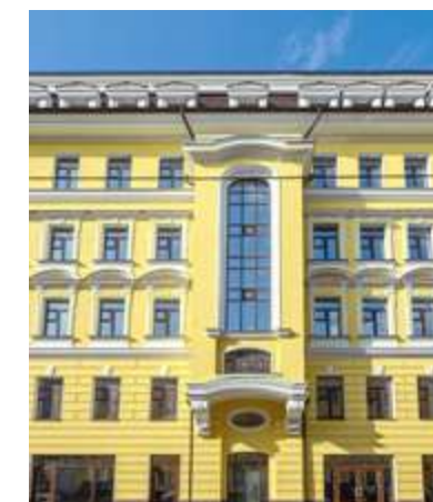
НОВЫЙ БАЛЧУГ Бизнес-центр Москва
